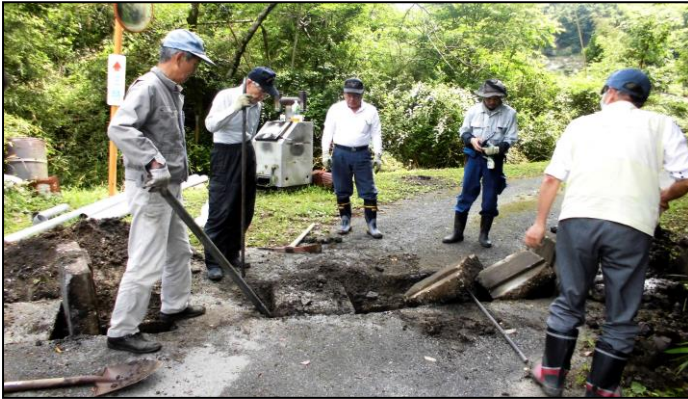
50キロほどの溝ぶたを起こして、溝の泥かき
