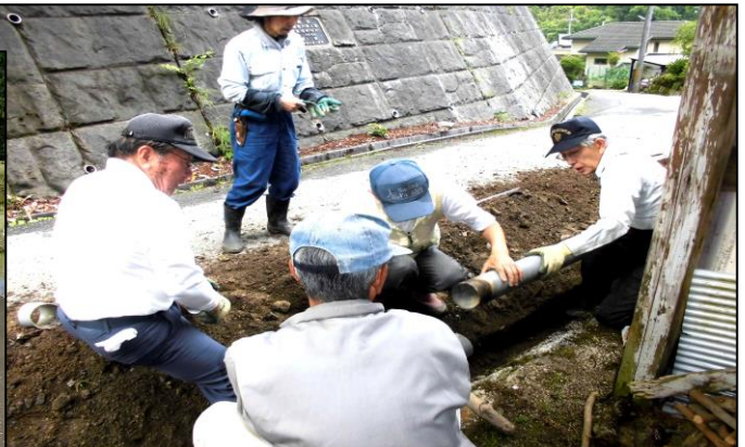
溝を掘ってパイプを埋める
